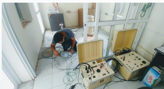
Lắp đặt hệ thống đo cao áp Set-up high-voltage tester system
